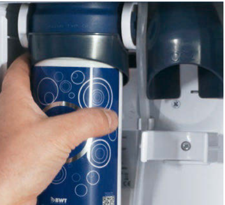
Skruva sedan i filtret i filterhuvudet och placera kylaren i skåpet i de borrade hålen.
