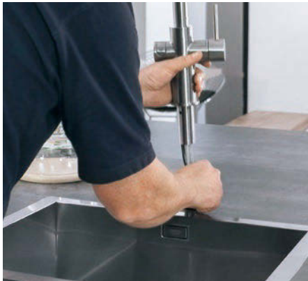
Placera kranen i rätt läge och montera den med tillhörande sats under skåpet.
