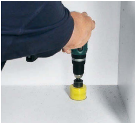
Använd ventilationsmallen och borra hål för ventilationen.
