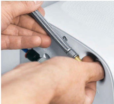
Anslut slangarna till kranen och till kylaren. Öppna sedan hörnventilerna innan du kopplar på strömmen.
