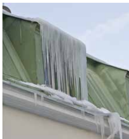
Värmeläckage ger näring åt istappar.
